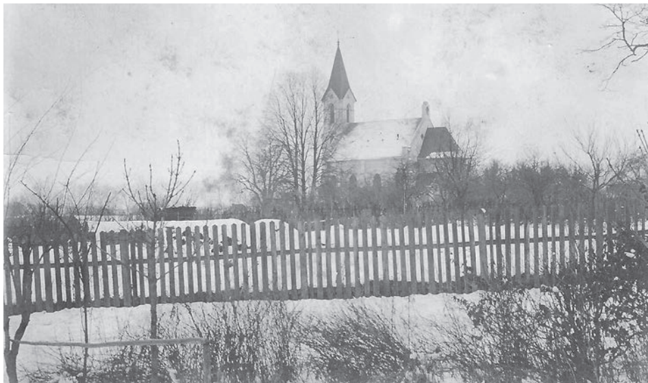
Widok na kościół w Żurawicy od strony południowo-wschodniej (parku). Na obu fotografiach widoczny oryginalny kształt wieży kościelnej (ze zbioru Macieja Dudy)
