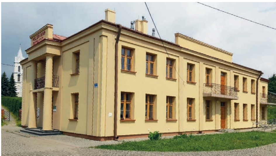
Polski Dom Katolicki po remoncie, strona zachodnia i południowa z dobudówką (fot. Elżbieta Dybek)
