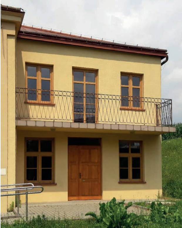
Dobudówka Polskiego Domu Katolickiego z podjazdem dla osób niepełnosprawnych (fot. Elżbieta Dybek)
